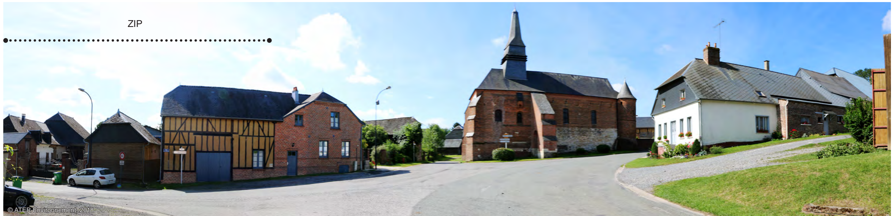
Fig. 98 : Eglise d'Archon, vue en direction de la ZIP fortement restreinte par la densité du front bâti
