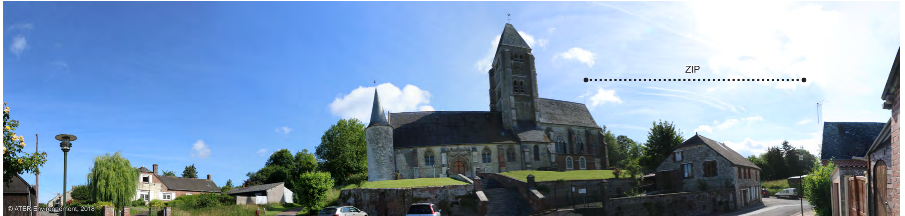
Fig. 97 : Eglise de Chaourse, vue en direction de la ZIP fortement limitée par le contexte bâti
