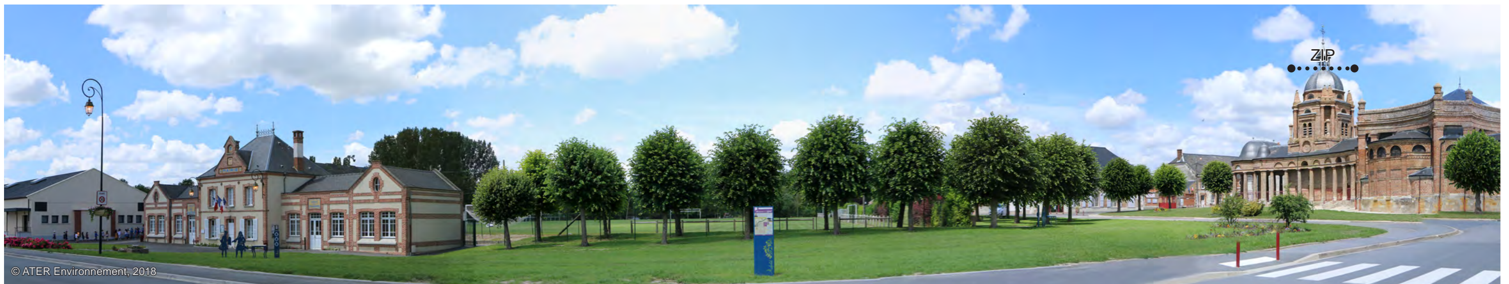
Fig. 67 : L'Église classée de Saint Didier à Asfeld, au sein d'un site patrimonial remarquable
